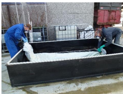
Vouw het zeil dicht op in de Heliosec® of Remdry® .
