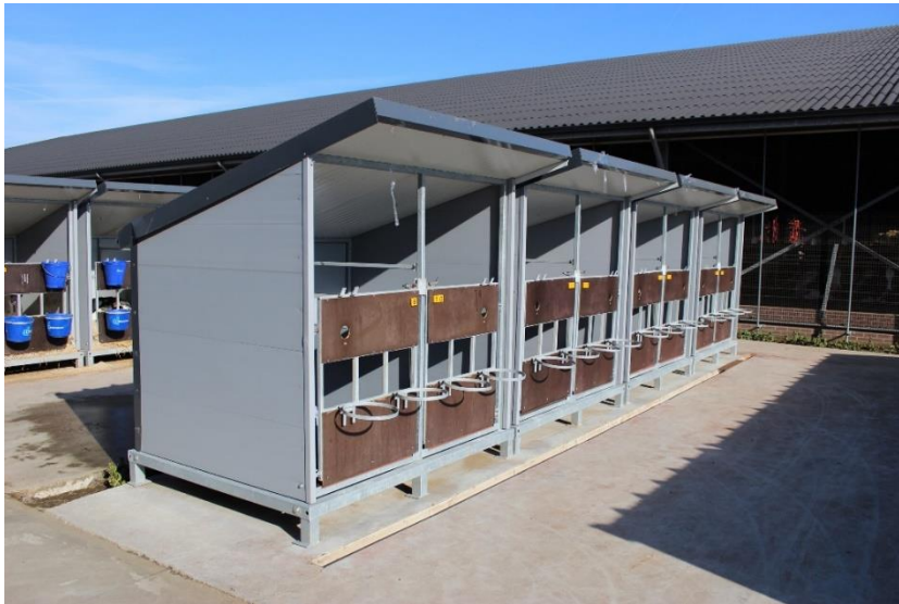
Figuur 10. AB-Loonconstruct kalverhok Op een hellend betonplein waarbij regenwater en mestwater gescheiden afgevoerd wordt.
