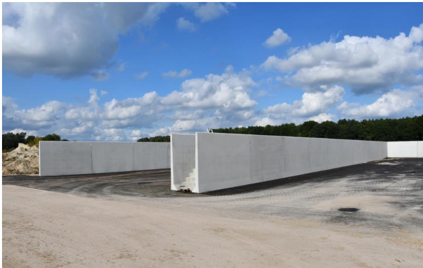
Figuur 8. CBS beton – sleufsilo
