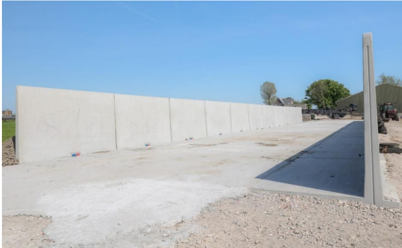
Figuur 7. Bosh Beton sleufsilo
