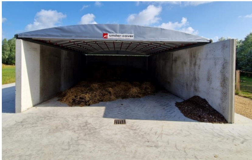
Figuur 14. 2Cover - Overkapping mestopslag met schuifbaar systeem
