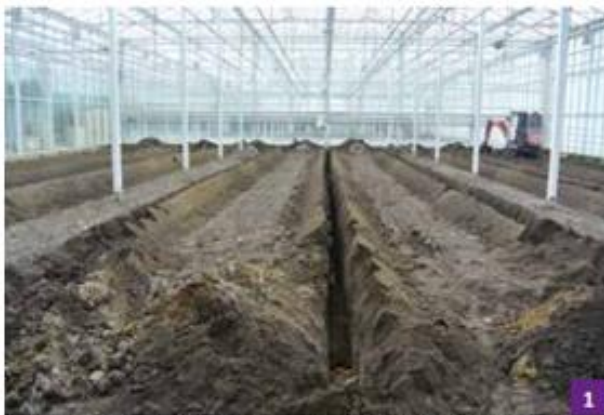
Aanleg stoomdrainage door L. Christensen. De zuigdrains zijn om de 2,67 meter ingegraven. Op het einde gaat de hoofddrain naar buiten en mondt uit in de pompput.
